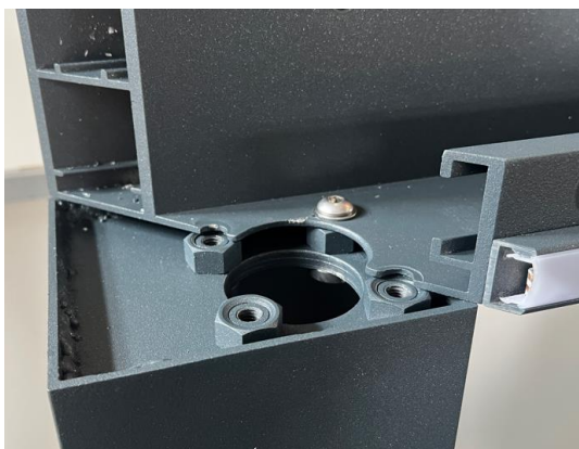
Rys. 5. Połączenie belka B01 z słupem S01.
