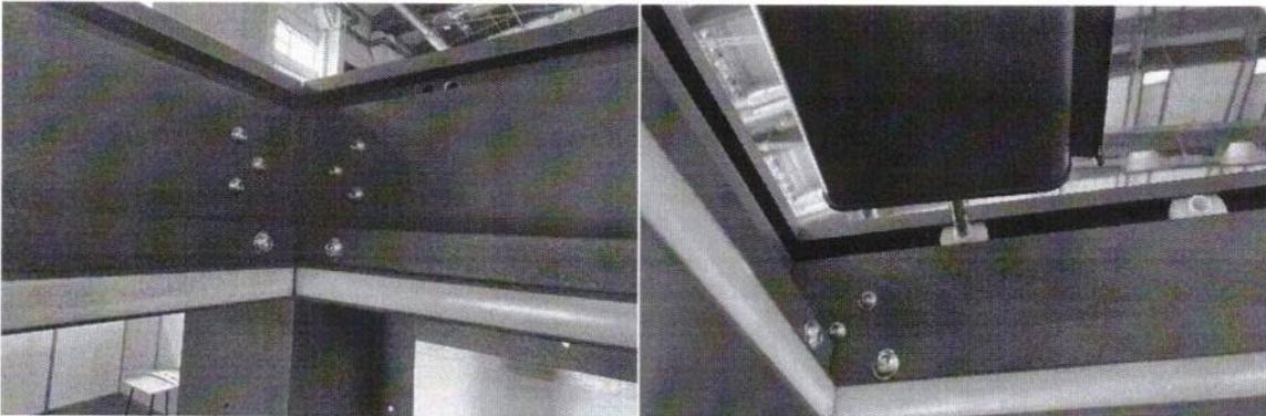
Abb. 7. Anschluss der B01-Träger an die S01-Säule auf der Innenseite.
